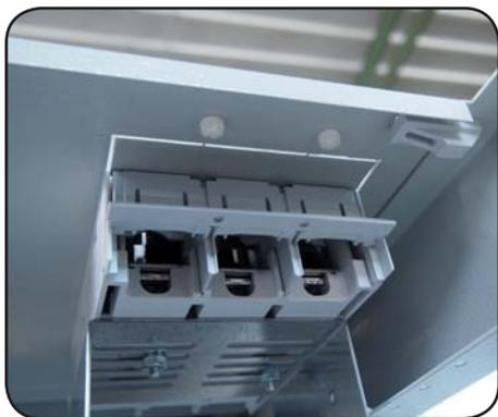
M5 Gewinde in die Berührungsschutzabdeckung schneiden.
