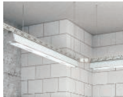
Anwendung Leuchenträgerschiene Abhängung der Leuchenträgerschiene mit Kette und Aufhängebügel.
