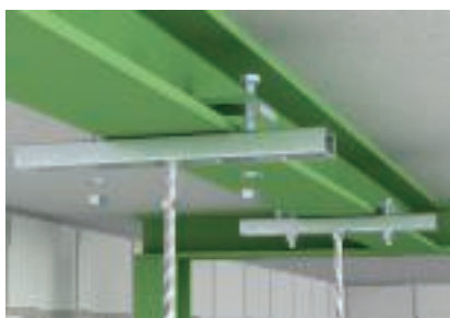
Stahlklemmung C-Profilschiene Befestigung eines C-Profils Typ CPS 4 G oder CPS 5 G an Stahlträger mit Hilfe von Klemmwinkeln Typ KWS.
