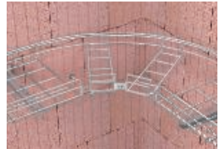
Horizontalbögen Realisierung eines Horizontalbogens bei C-Gitterrinnen mit Eckverbinder Typ GEV 36.
