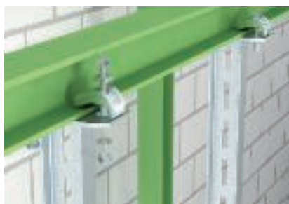
Direkte Stahlklemmung Direkte Stahlklemmung eines I-Hängestieles mittels Spannklau (schwer) Typ TKS-S-30. Trassenverlauf längs zum Stahlträger.
