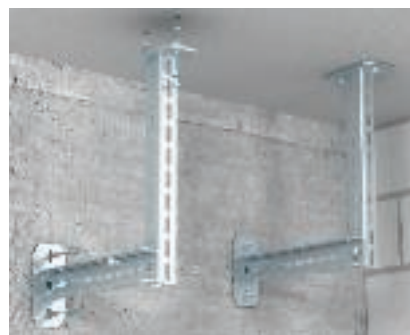
Sonderkonstruktion Sonderkonstruktion aus U-Profilen zur Aufnahme eines Kabeltragsystems.
