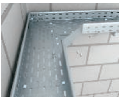
Bogenerstellung mit Eckverbinder Bei bauseits zu erstellenden 90°-Bögen kann zur Vergrößerung des Innenradius der Eckverbinder Typ REV eingesetzt werden.
