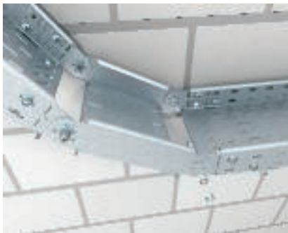
Montage Gelenkbogen-Element vertikal Montage des Gelenkbogen-Elements vertikal zur Herstellung von Gelenkbögen. Das Gelenkbogen-Element wird mit Gelenkverbindern mit der Kabelrinne verbunden.
