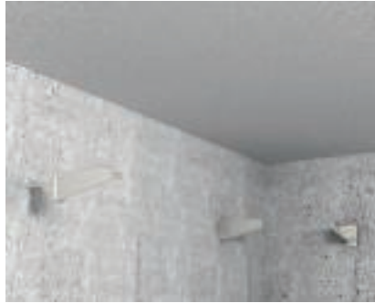
Wandmontage Direkte Befestigung von Wand- und Stielauslegern Typ AW... auf der Wand.
