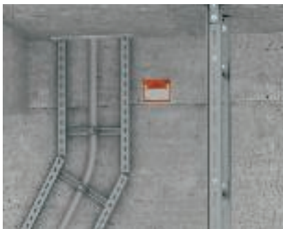
Anwendung Richtungsänderung Realisierung einer Richtungsänderung bei Steigeleiter schwer Typ SLM.
