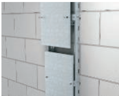
Deckelmontage vertikal Montage des Deckel mit Abstandhalter an einer vertikalen Steigeleiter.
