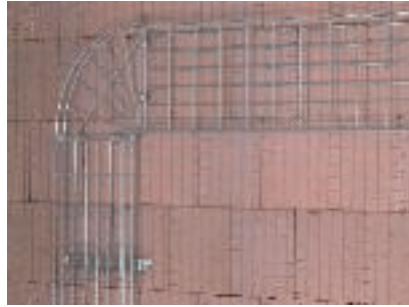
Anwendung Wandmontage Wandmontage von C-Gitterrinnen und Bogen 90°.
