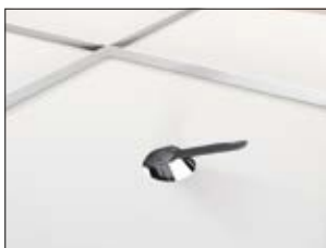
1. Einsetzen des Abstandshalters durch die Montageöffnung.
